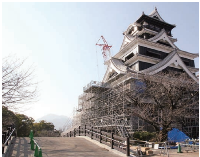
修復工事中の熊本城大天守
