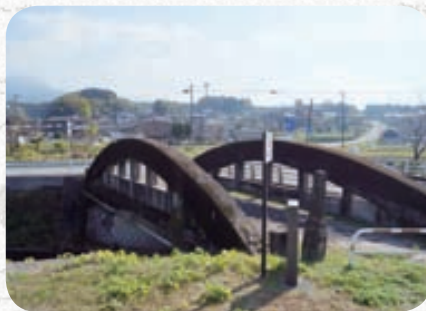
川に対し斜めに架かる姫井橋
